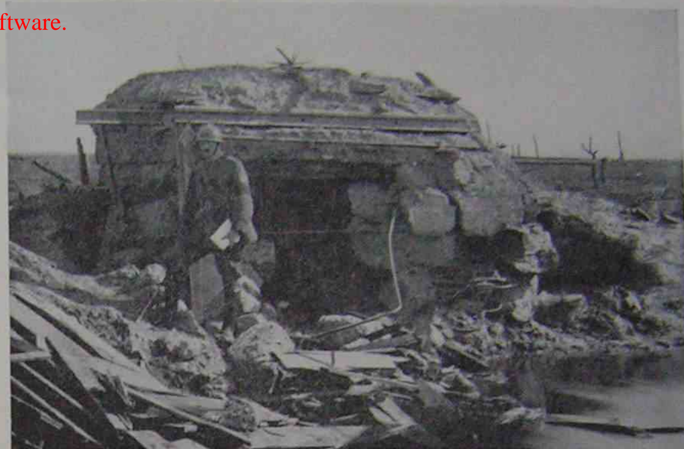
Betonschuilplaats te Merkem.
